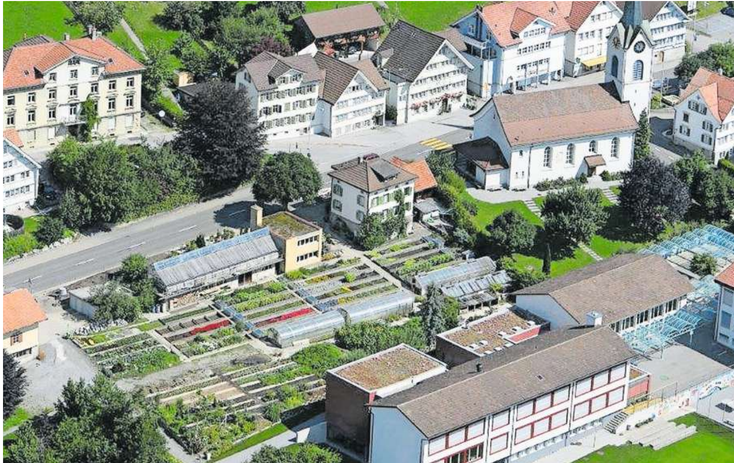
Wenn alles gut läuft, wird das Gebäude der Viola Floristik und Gärtnerei im Herbst abgebrochen. Neu gäbe es zwei Häuser und unten würde ein neues Gewächshaus gebaut werden. Bild: PD
